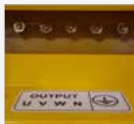
Bornes de connexion
